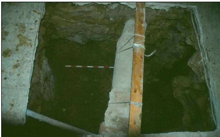
F10.: Vista final de la cala.
